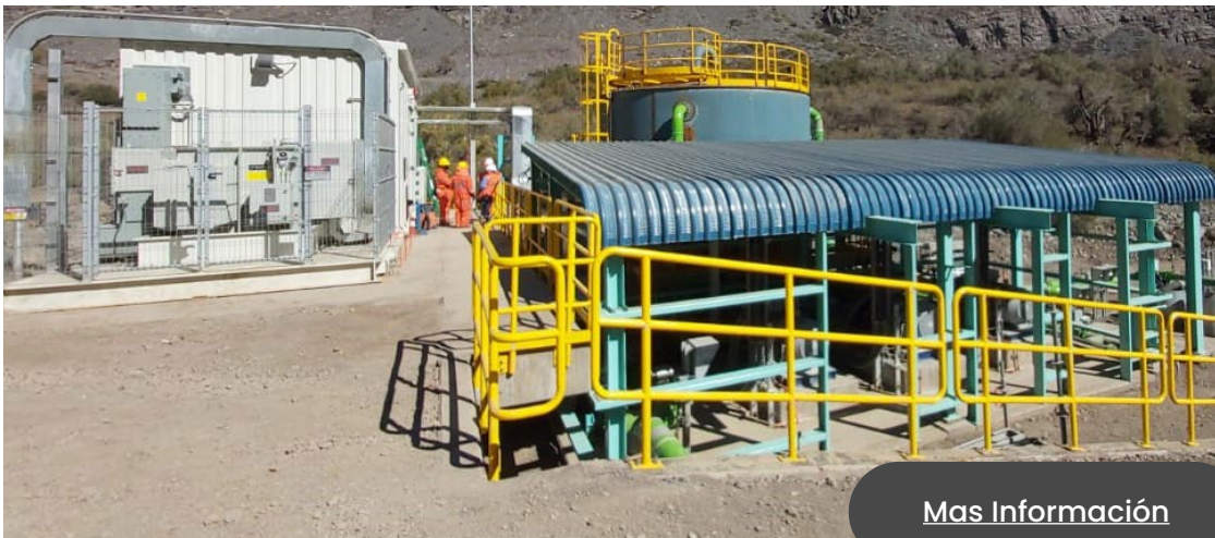
Construcción de obras de aseguramiento hídrico
